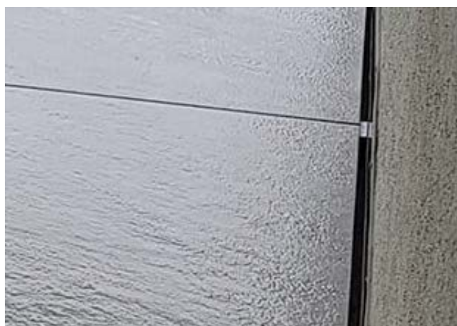
Fig. 35: Giunto di raccordo \geq 10 mm con distanziatore.
