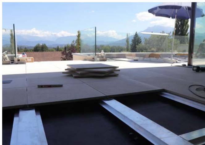
Fig. 7: Posa di piastrelle in ceramica/gres porcellanato su sistema a binari.
