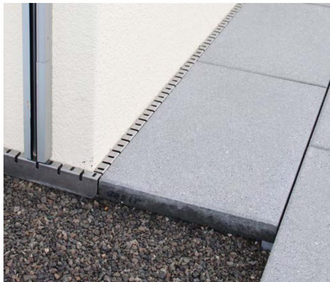
Fig. 33: Raccordo perimetrale con profilo di giunzione.
