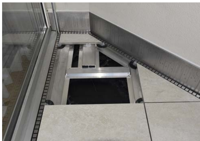
Fig. 20: I sistemi a binari si prestano a una posa ottimale delle pavimentazioni di mattonelle/piastrelle e in particolare consentono un'esecuzione a regola d'arte in presenza di raccordi ortogonali difficili.
