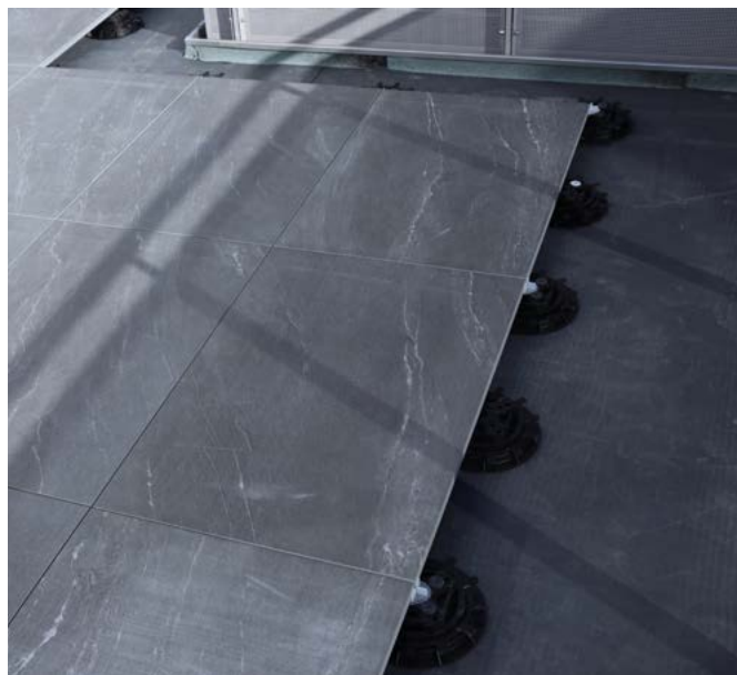
Fig. 26: Terrazza con piastrelle in ceramica/gres porcellanato posate su basi d'appoggio.
