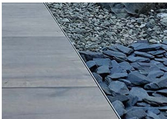
Fig. 34: Raccordo perimetrale con staffa metallica o distanziatore.
