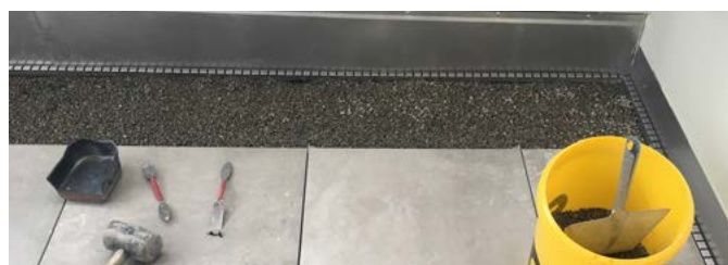
Fig. 5: Posa delle piastrelle in ceramica/gres porcellanato su strato di allettamento di ghiaia tonda.
